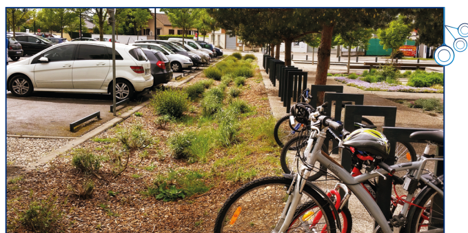
Figure 18 : Exemple d'ouvrage de gestion à la source des eaux pluviales : des jardins de pluie à Meyzieu, près de Lyon (Source : OTHU, N. Cossais)
