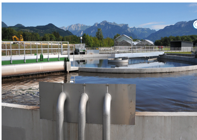
Figure 10 : La STEU de Bellecombe en Haute-Savoie (Source : Rilact)
