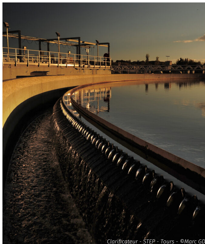
Clarificateur - STEP - Tours - ©Marc GD
